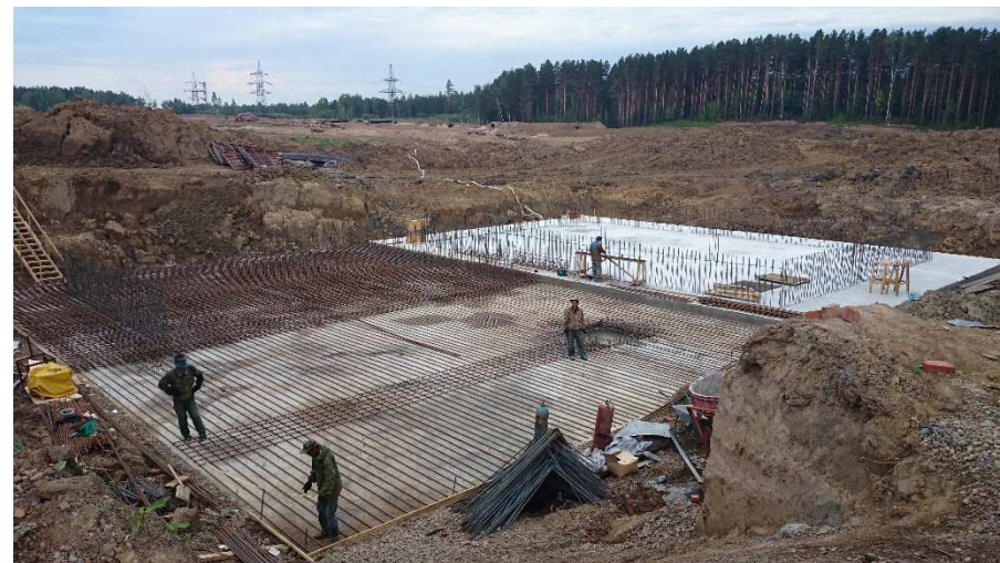
монтаж водонапорной станции
