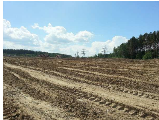
выравнивание, отсыпка территории
