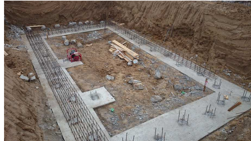
монтаж резервуара РЧВ
