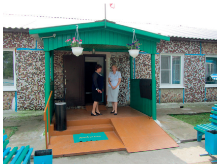
Фото пандуса в доме престарелых в Первомайском районе.
