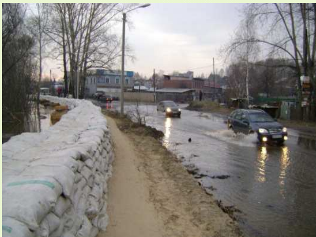
Берегоукрепление по Б. Хмельницкого
